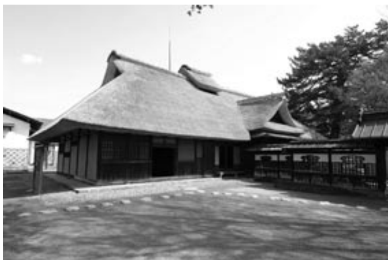
保存修理工事竣工の様子
