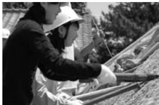
小学生による茅葺屋根の葺き替え体験
