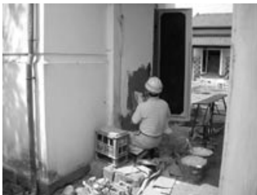
保存修理作業の様子
