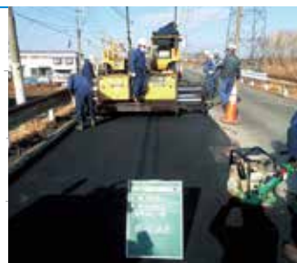
道路改修工事
