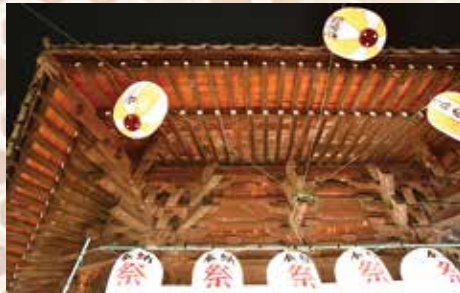
屋根は土蔵建築に特徴的な「置き屋根」で、三手先組み物という豪壮な組手によって支えられている。昭和13年の写真ではまだ見られないが、現在は垂木の小口（先端）が白く塗られている。
