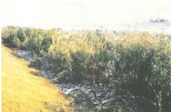
●石積みに柳を植え付けた柳枝工護岸 ・矢作川の護岸 [愛知県岡崎市]
