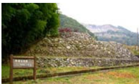
○御勅使川石積出し
