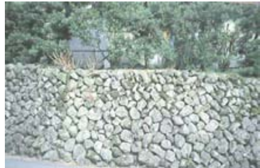
●小動物の居住環境となる石垣（空石積）
