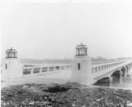
旧信玄橋 親柱上に橋灯が見える
