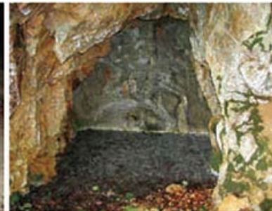
コンクリートで塞がれている坑道入口
