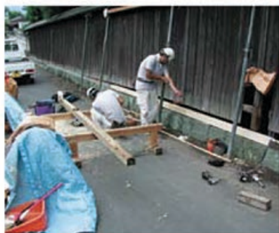
板塀の修復風景
