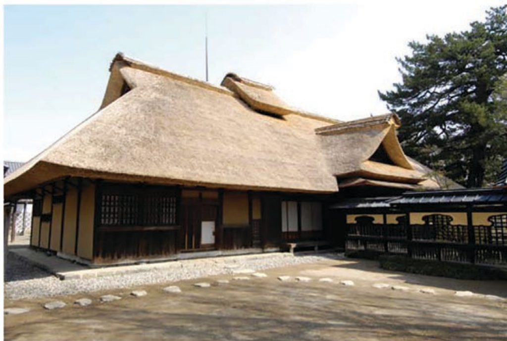
葺き替え後の安藤家住宅
