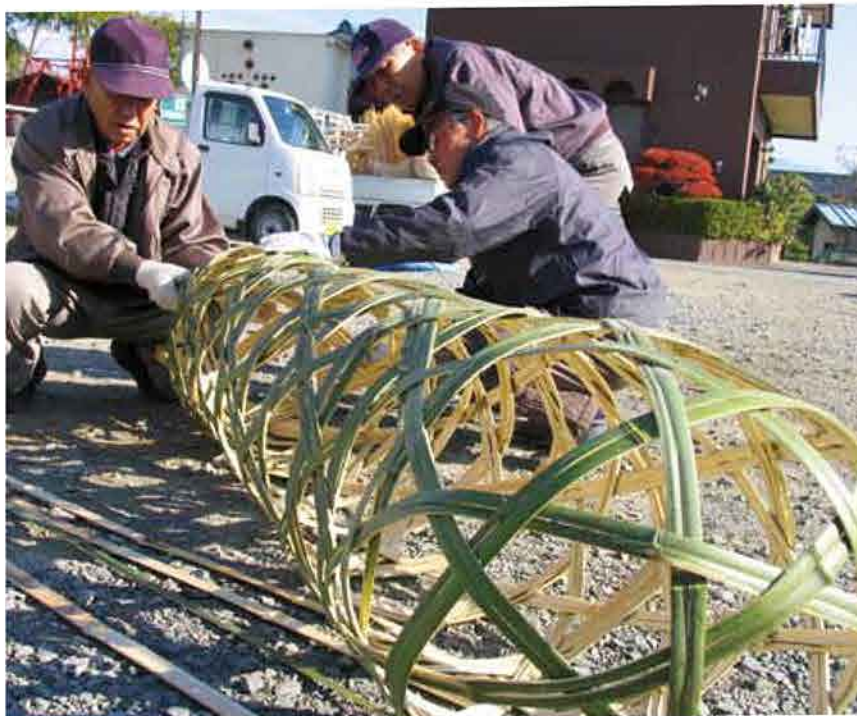
細部を確認して完成。この後籠の中に石を投げ入れます。
