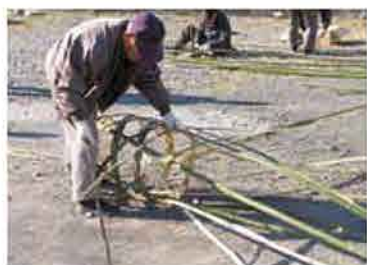
広がらないように引締めながら、同じ太さになるように調節。
