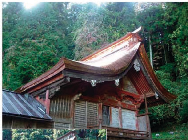
修復後の本殿
