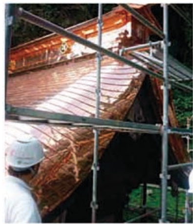
屋根の葺替工事の様子
