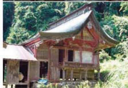
修復前の本殿
