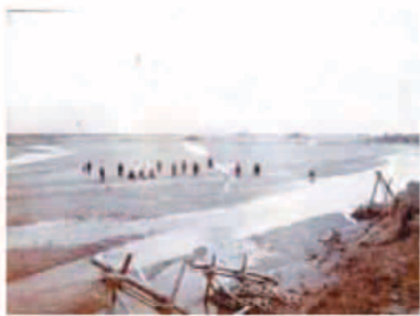
明治40年水害後の将監堤付近 右奥に見える土手が将監堤。洪水により寸断されている状況がわかる。
