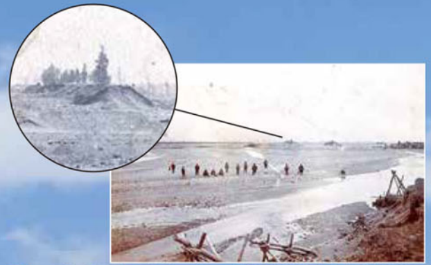
明治40年(1907)の水害の様子。避水台北側の将監堤が流失し、周囲は釜無川が運んだ砂礫に埋め尽くされている。一方避水台部分は、なんとか流失を免れた。堤防上のひとときわ大きな木が一本杉か。
