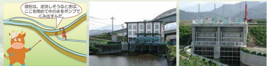
戸田・宮沢地区を守る五明の排水機場(左)と五明樋門(右)
