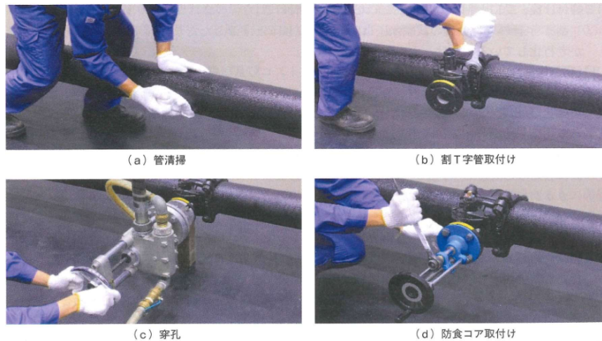
図Ⅲ-3-2 割T字管の取り付け作業工程
