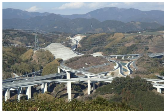
新清水 JCT（山梨県 HP(提供 NEXCO 中日本)）
