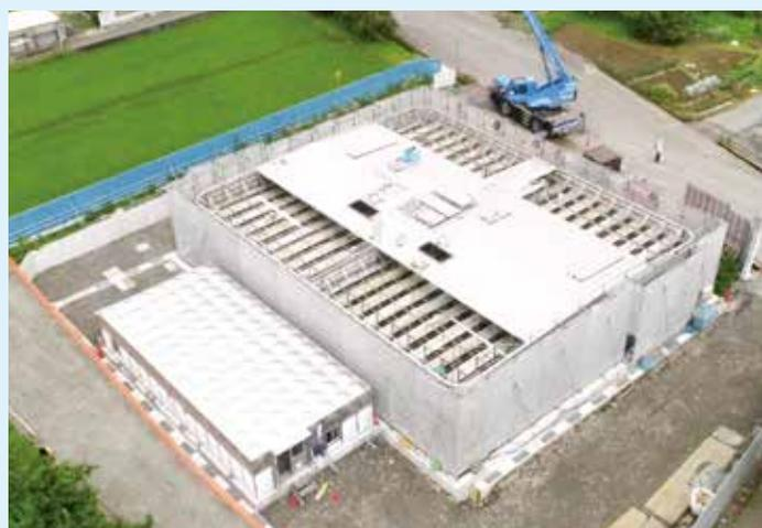
南アルプス市では、安心して安全な水道水を将来に渡り安定的に供給するために、飯野新田地内に新しい配水池の建設を進め、今年度に完成する予定です。この配水池は、最大で2,500m<sup>3</sup>（ドラム缶12,500本分）の水が貯められます。また、地震にも対応できるように耐震性能の高いステンレス製とし、震度5強で作動する緊急遮断弁を備え、災害時における水を確保する役割を担います。
