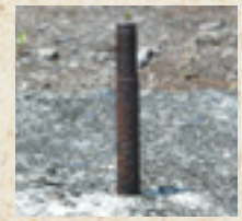
掩体壕の木製の屋根と基礎はこのようなボルトで連結されていた。
