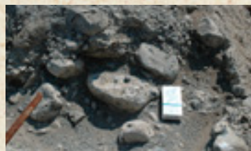
コンクリートに混入していた礫
