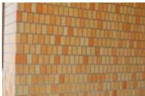
タイル張り、石張り
