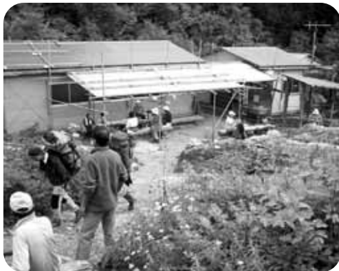
改築される白根御池小屋
