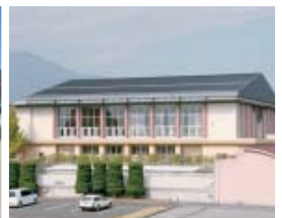
▲白根巨摩中体育館
