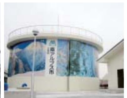
▲十日市場配水場
