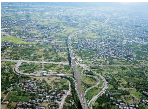
南アルプスICから開通区間を望む
