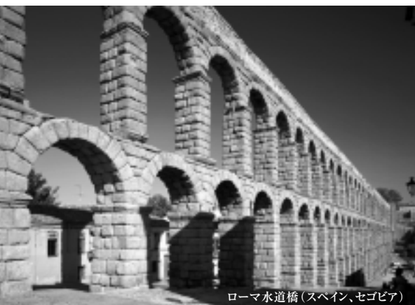
ローマ水道橋(スペイン、セゴビア)
