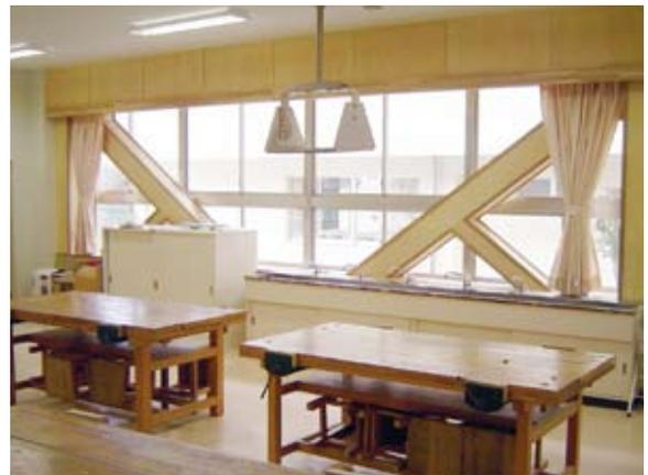
耐震補強を図るため、窓枠にブレース(筋交い)を入れた教室
