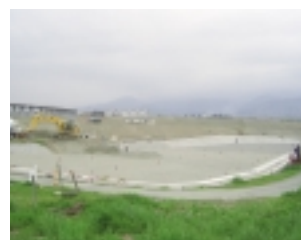
(株)バイオニアの新工場建設予定地(造成工事中)
