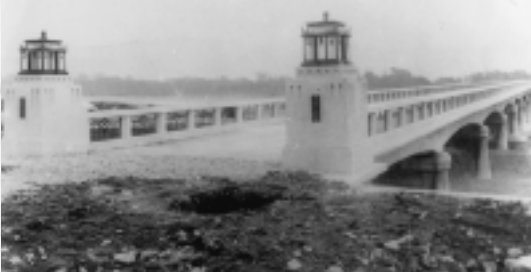
旧信玄橋 親柱上に橋灯が見える
