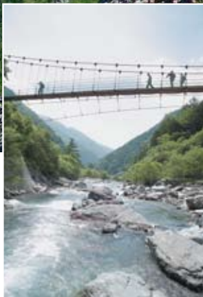
広河原の野呂川にかかる吊橋
