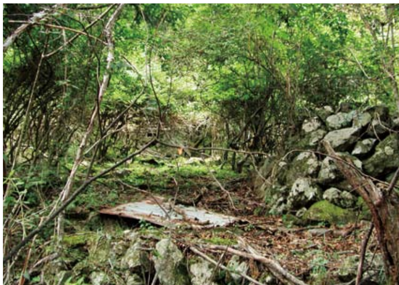
建物は崩れているが当時の面影を伝えている住居跡
