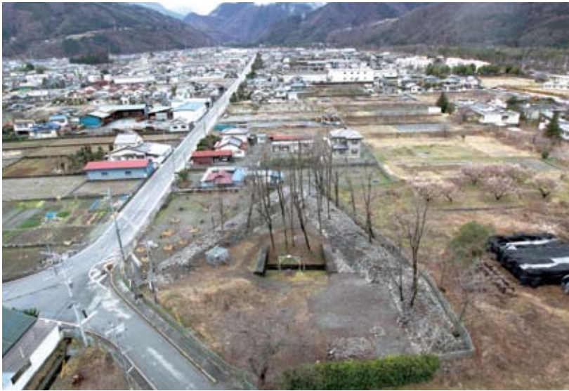
枅形堤防内に見えるのが徳島堰から後田堰へ取水するための取水口で、暗渠から一度開口している様子がよくわかる。(県立わかば養護学校付近上空から西方向を写している)
