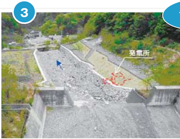
金山沢川砂防えん堤下流の状況
