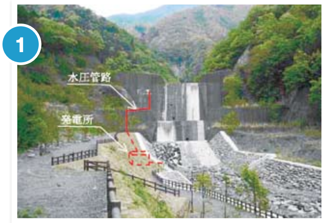
発電所建設予定地周辺
