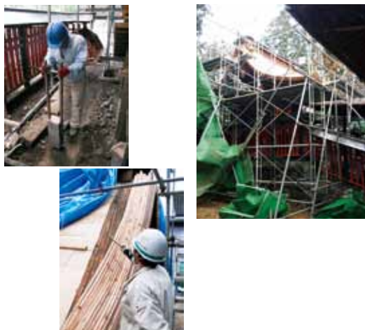
修復工事の様子
