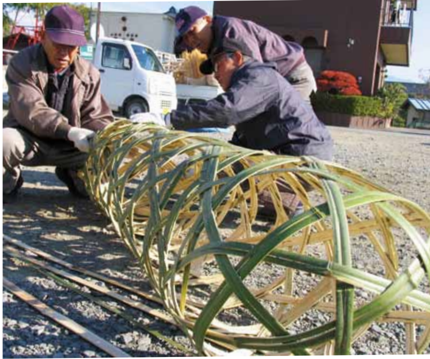
細部を確認して完成。この後籠の中に石を投げ入れます。
