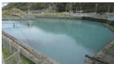
②沈砂池(一旦大きな池で砂やゴミを沈めます)
