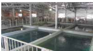
④フロック形成池(水の中のゴミや濁りを小さな固まりにします)
