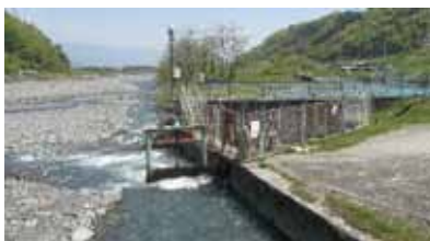
①取水口(御勅使川から取水)
