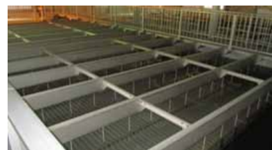
⑤沈殿池(フロックを沈めます)
