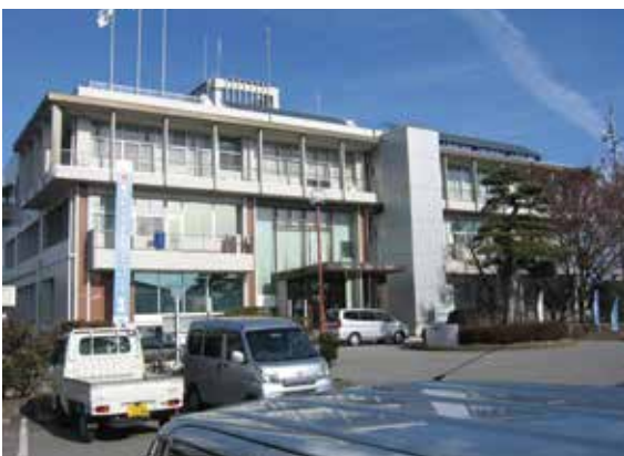
▶本庁舎の改修は、主に一階の窓口を中心に行ないます。 耐震補強なども行なうため、一時的に窓口は耐震棟へ移ります。
