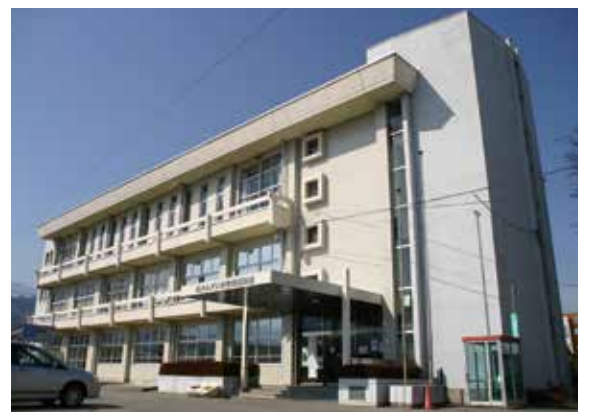
▶西別館の改修工事は始まっています。
