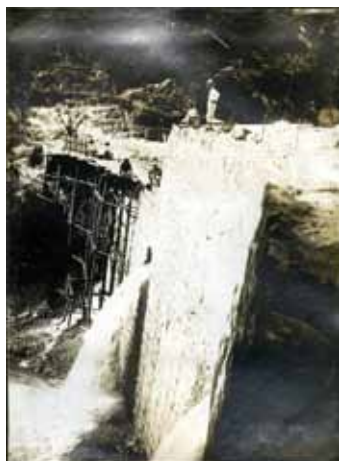
芦安堰堤アーチ式工事写真
