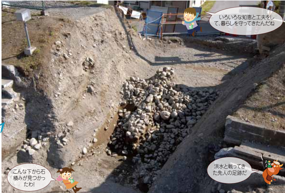
7. 最下層から発見された堤防。中央には竹蛇籠が1本置かれています。この下にもさらに古い堤防が造られているかもしれませんが、時代は江戸時代の可能性があります、今後の検討課題です。
