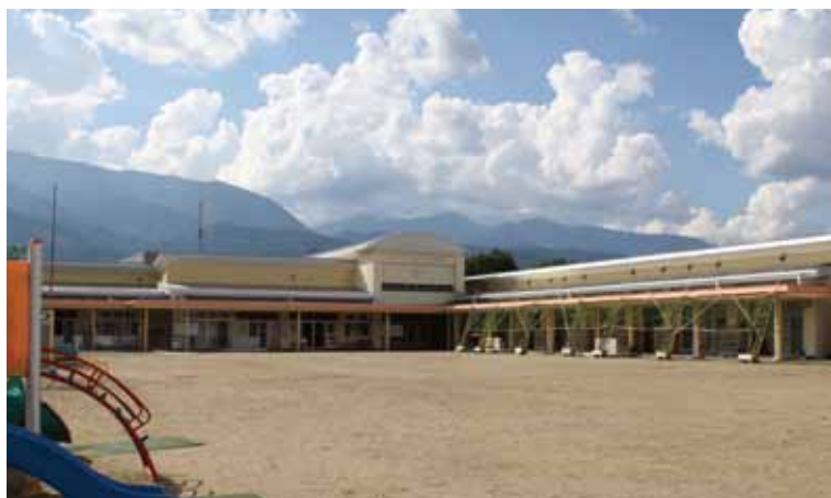
大井・大明保育所を統合した新大明保育所
