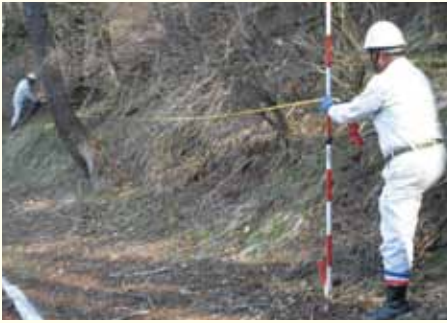
コース設定のための測量を実施
