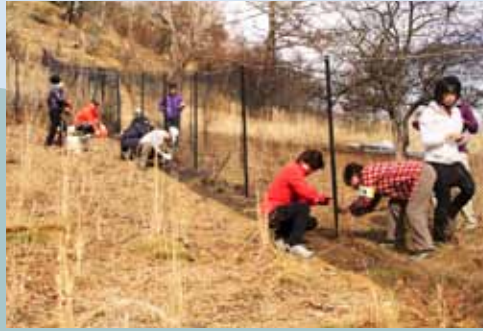
鹿防護柵設置作業（櫛形山）
