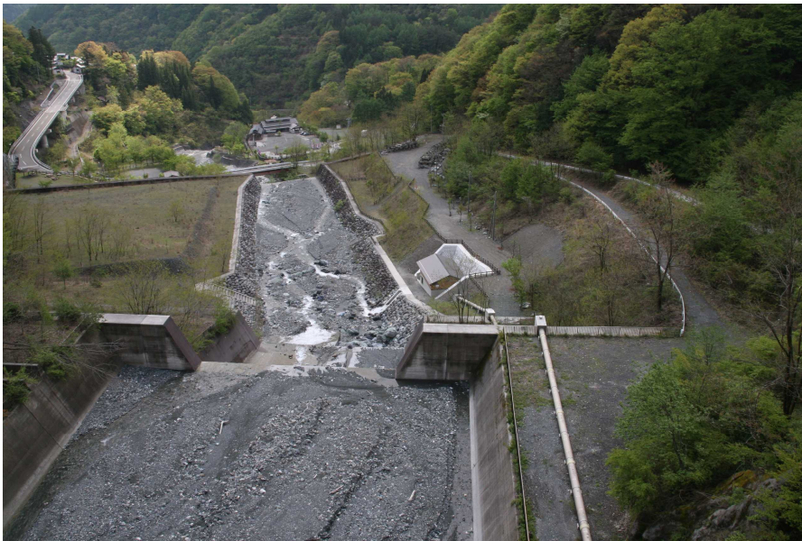
写真③ 上流から見た発電所周辺
