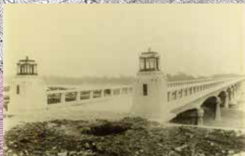
昭和7年に完成したコンクリート製の初代信玄橋。 田之岡村や御影村念願の永久橋です。
