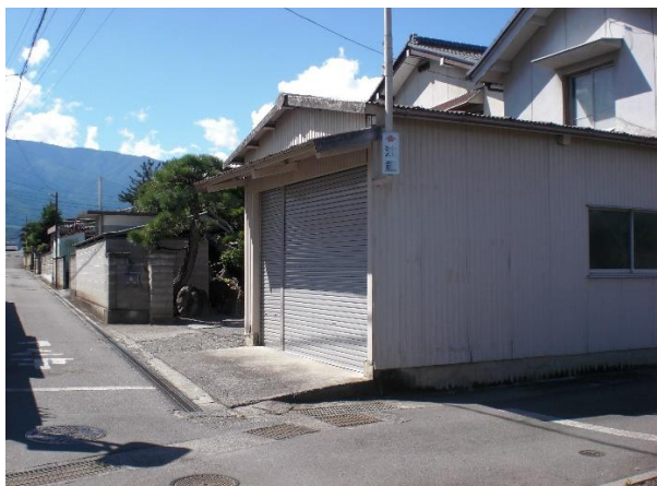
⑤ 東側から 取り付け道路・車庫
