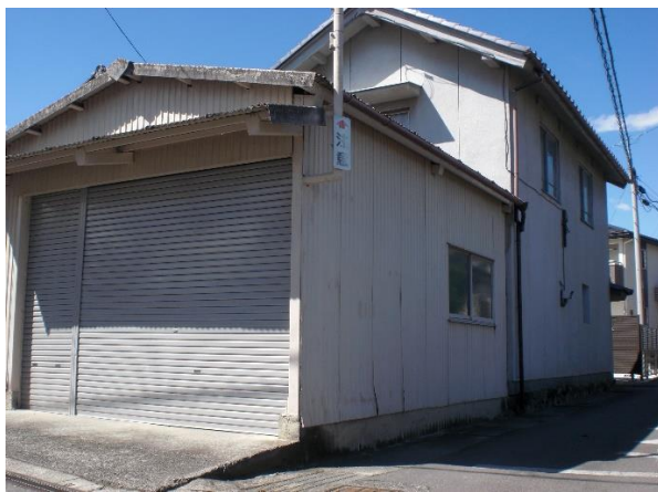
④ 南東側から 車庫・倉庫
