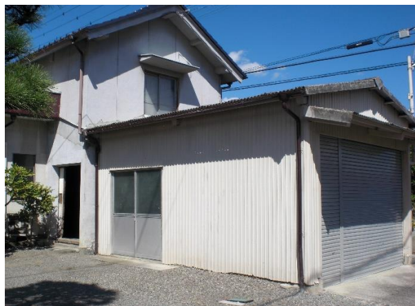
③ 南側から 倉庫・車庫
