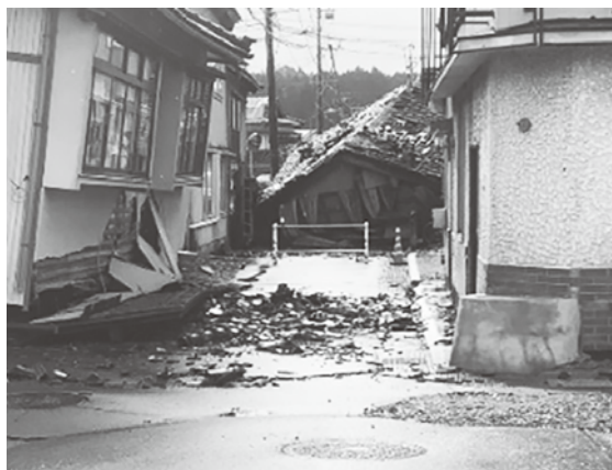
石川県穴水町の被災状況
