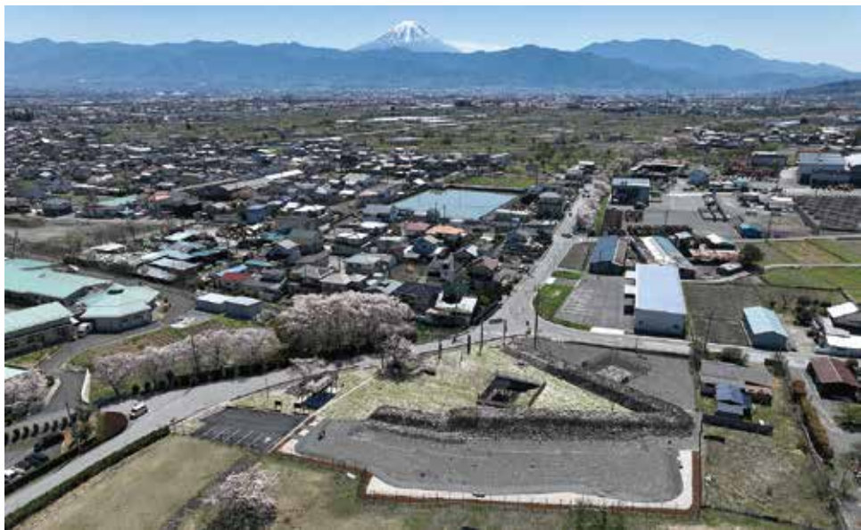
整備された榊形堤防の全景
