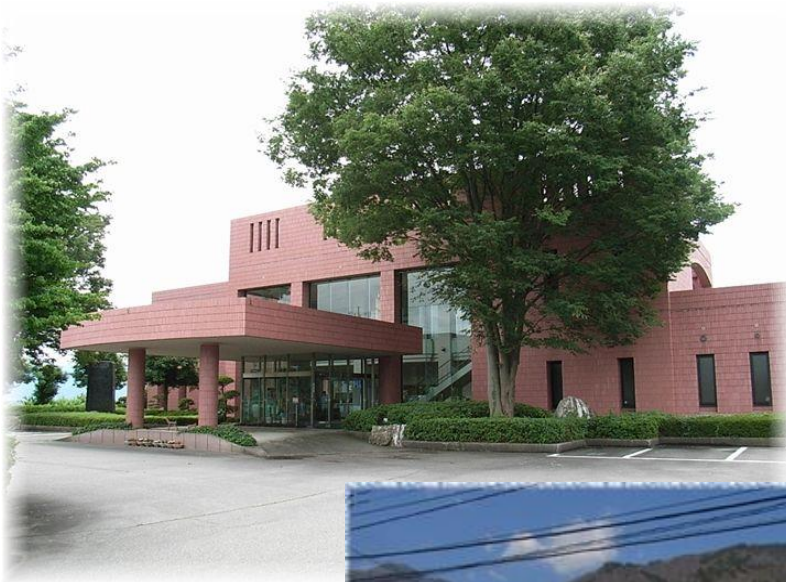
南アルプス市上下水道局庁舎
