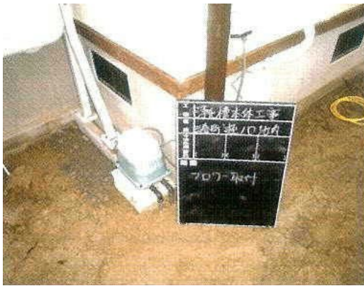
【写真⑦】 ブロア設置状況を示す写真
