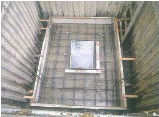
【写真2-3】基礎工事の配筋状況を示す写真
