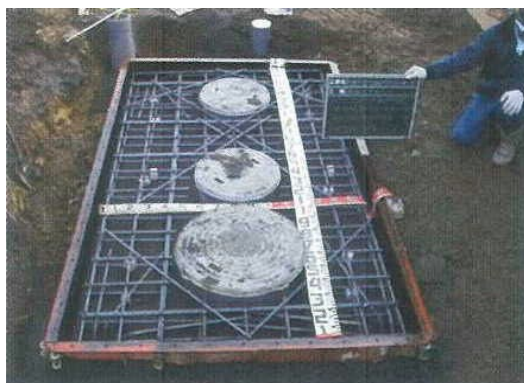
【写真⑥】 上部スラブ工事を示す写真
