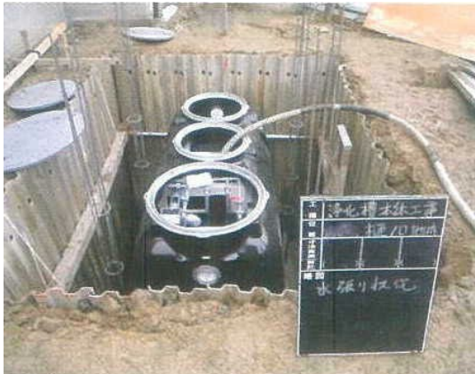
【写真④】 据付工事の状況を示す写真
