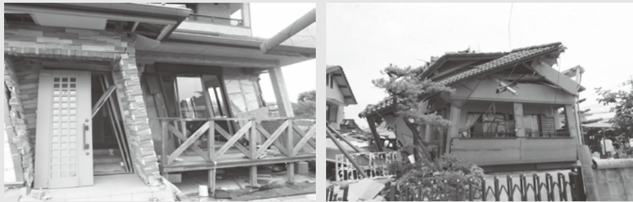
昭和56年6月1日以降の安全とされた木造住宅の被災状況
