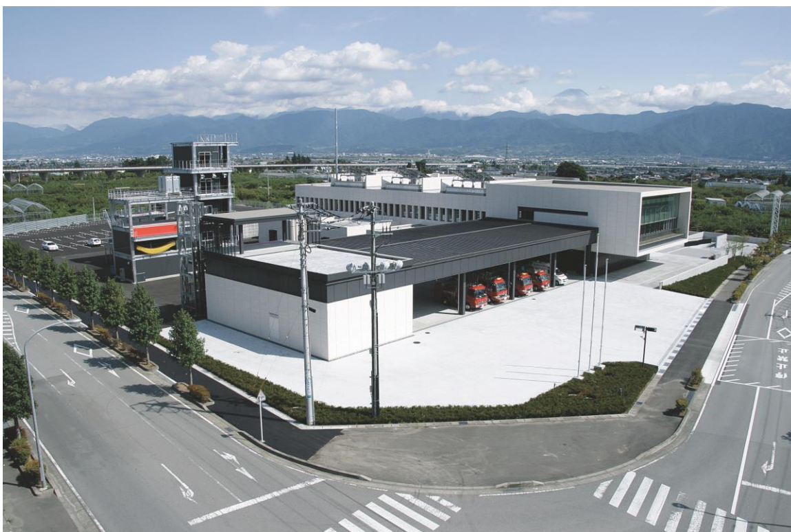
「消防本部庁舎」
