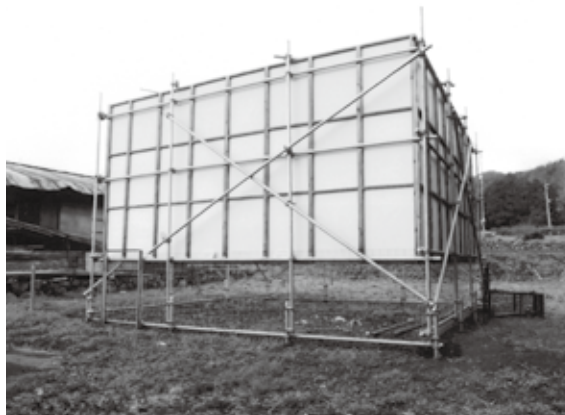
平岡地区に設置した獣害対策用の大型囲い罠
