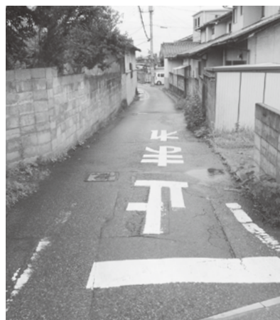
市内の狭隘道路のようす
