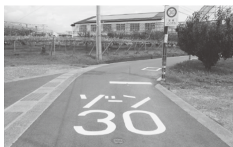
安全を確保するため整備された通学路
