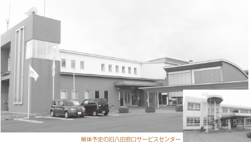
解体予定の旧八田窓口サービスセンター
