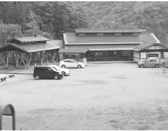
休憩室が改修される予定の金山沢温泉
