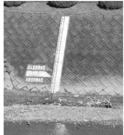
滝沢川に設置されている水位計
