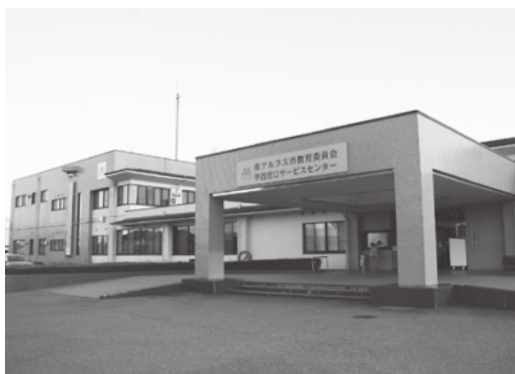
エレベーターが設置される甲西支所
