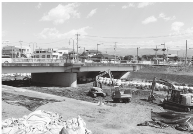
耐震補強工事中の楕形大橋
