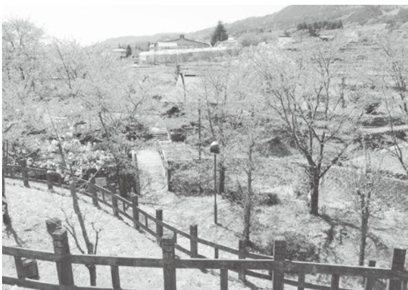
災害復旧工事が行われているほたるみ橋公園
